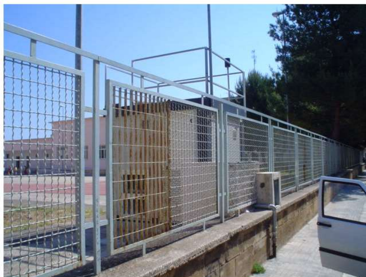
Figura 8 Foto della centralina sita sulla via Filzi a Francavilla Fontana
